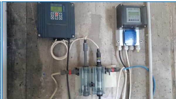
Système de chloration (utilisé ponctuellement)
