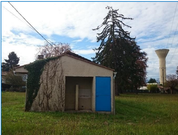
Vue extérieure d'ensemble
