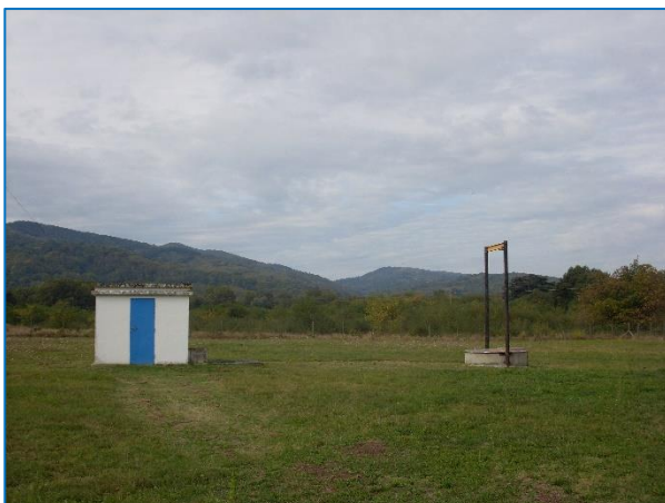
Vue extérieure d'ensemble
