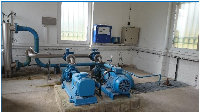
Pompes d'aspiration et traitement UV
