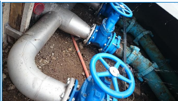
Système de chloration (utilisé ponctuellement)
